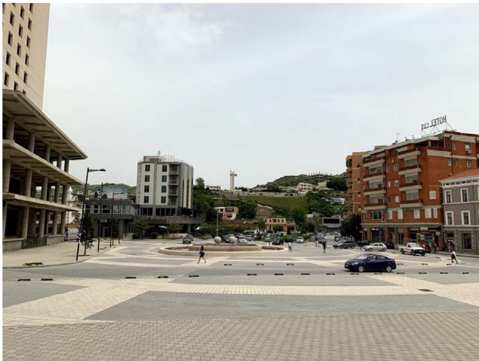
Situata ekzistuese e rrugës kryesore që kalon në mes të sheshit Flamuri
