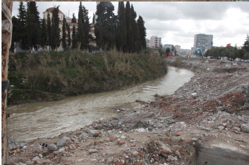
Foto të gjendjes ekzistuese
