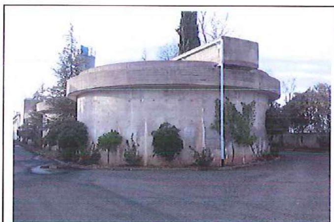
Fig 22. Gjendja ekzistuese e vaskave te dendesimit te llumit
