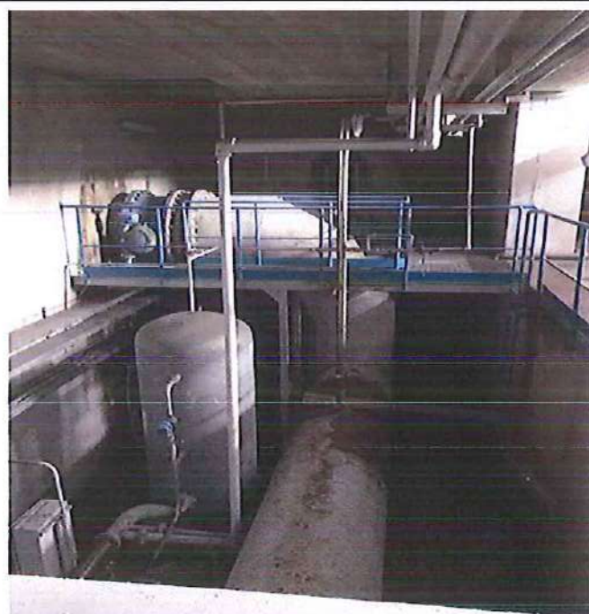
Fig 23 . Gjendja ekzistuese e vaskave të dendesimit të llumit
