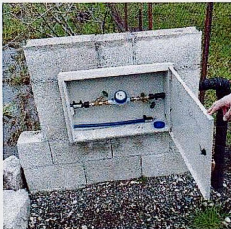
Figure 52: Lidhje shtëpie, e instaluar së fundmi
