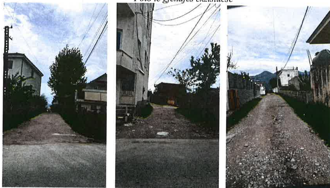
Foto të gjendjes ekzistuese
