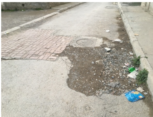
Fig 15. Segment i rrugës ekzistuese
