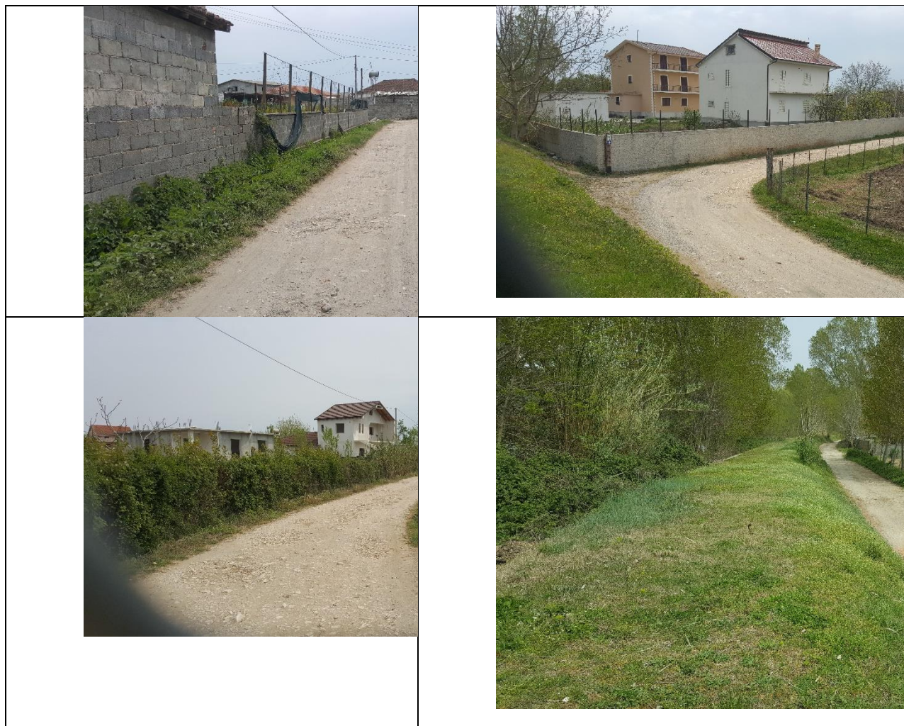
Foto te gjendjes ekzistuese
