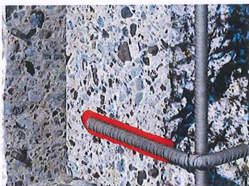
DETAJ I RIPARIMEVE TE MUREVE TE DENTUARA
