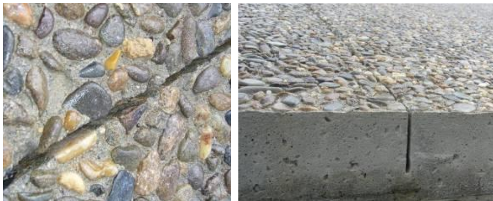
Shembul i carjeve pa shtremberim ne siperfaqen e betonit te lare
